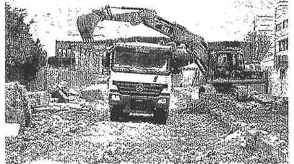
SCAVI Il cantiere nei pressi dell'ex stazione ferroviaria all'aeroporto
