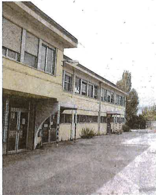
L'ormai ex sede della Motorizzazione a San Giuliano (MUZZI)
