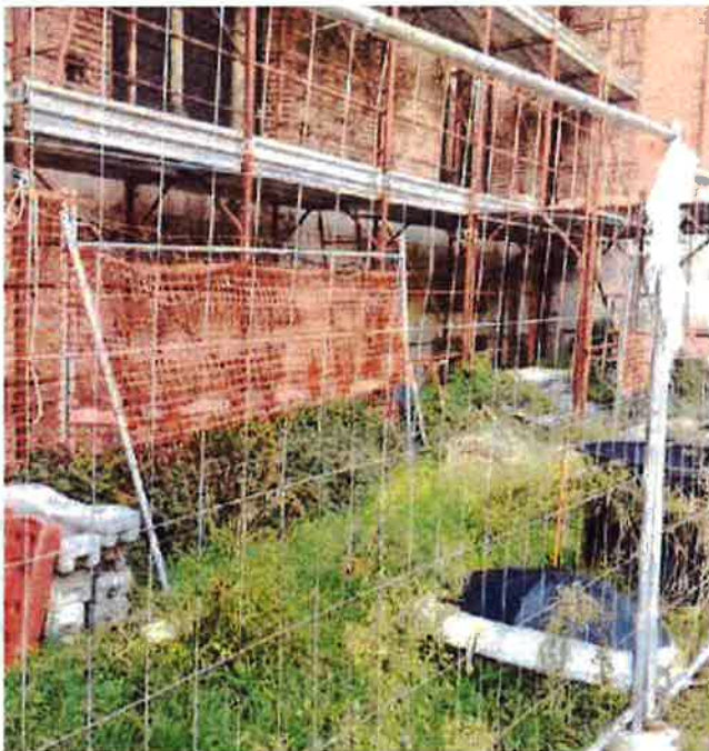
Il degrado nell'area del cantiere della chiesa di San Francesco
